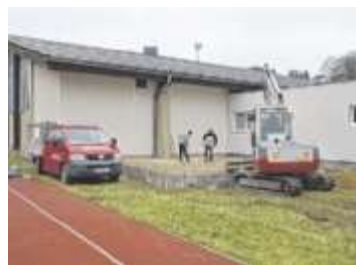
Arbeiten am Hallenzubau Foto: Six
