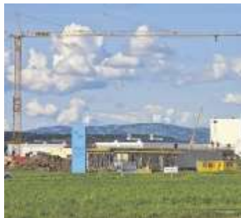
Betriebsbaugelände an der B1 in Gampern: www.be-one-gampern.at
